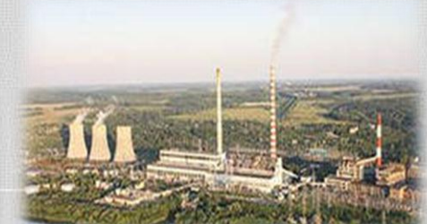
Каширская ГРЭС имени Г.М. Кржижановского Московская область 180 000 кв. м
