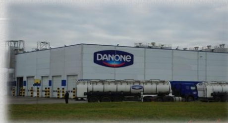
Завод «ДАНОН» Московская область 83 000 кв. м
