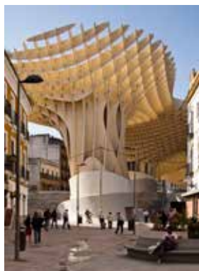
Хотя все считают навес деревянным, на самом деле в его основе — бетонная конструкция
